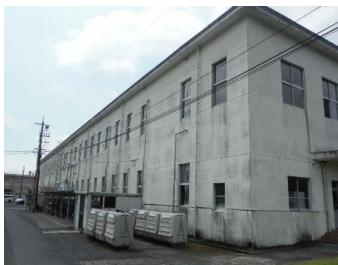
【現状施設の例(庁舎)】
